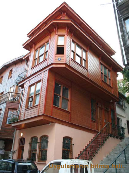
Kasa, pervaz, silme ve konsolların montajı.
