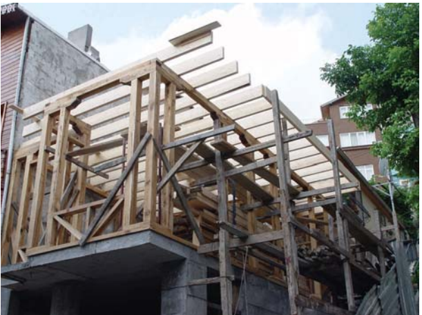
Üstte taşıyıcıların montajı. Alttaki kat döşeme kirişleri.
