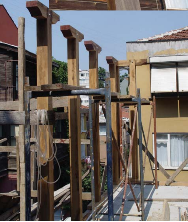
Üstte taşıyıcıların montajı. Alttaki kat döşeme kirişleri.
